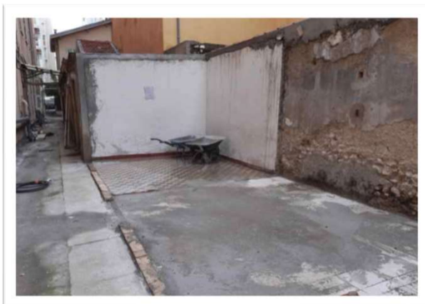
Démolition des caves extérieures
