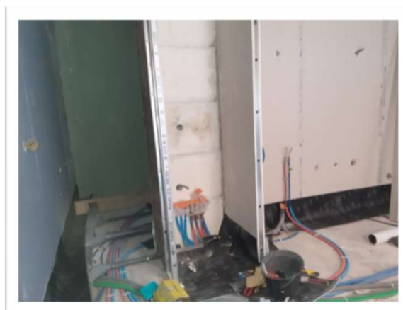
Incorporations des réseaux en cours
