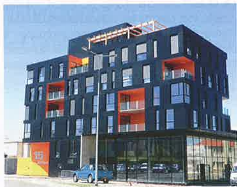
Un bâtiment en auto-construction : du sur-mesure pour Créquy et ses partenaires
