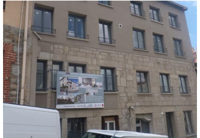
■ La façade en grès houiller de l'immeuble du 79-81, rue de l'Éternité, construit à l'origine en deux temps, a été remise à jour. Photo Pascale Bigay
