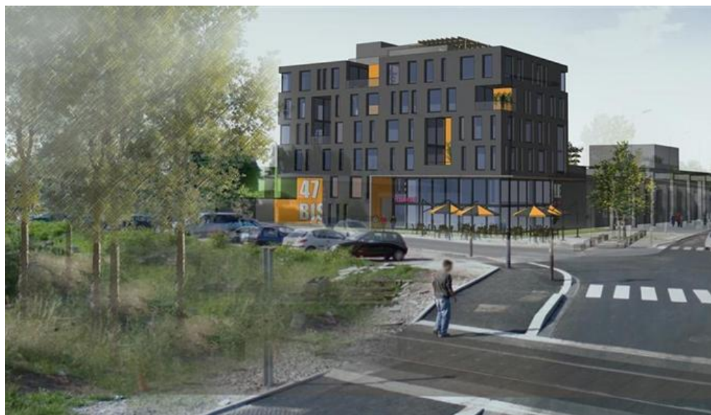
La perspective de l'immeuble depuis la rue des Acières. Cabinet d'architecte Frédéric Busquet
