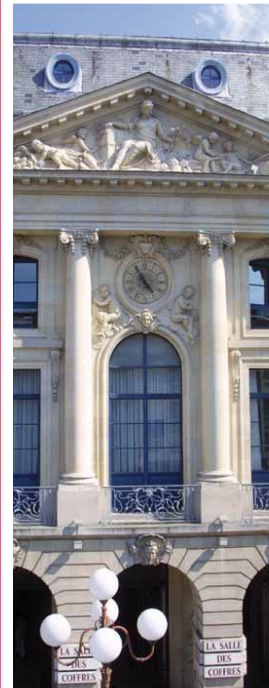
Démarré en ce début 2012, le chantier de rénovation du bâtiment de la Salle des coffres s'achèvera à l'automne 2013.
