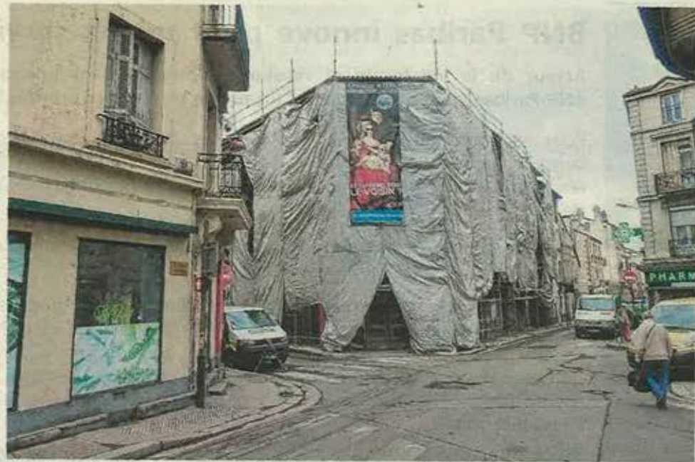
■ Derrière la façade dissimulée par une bâche, les travaux se poursuivent.
