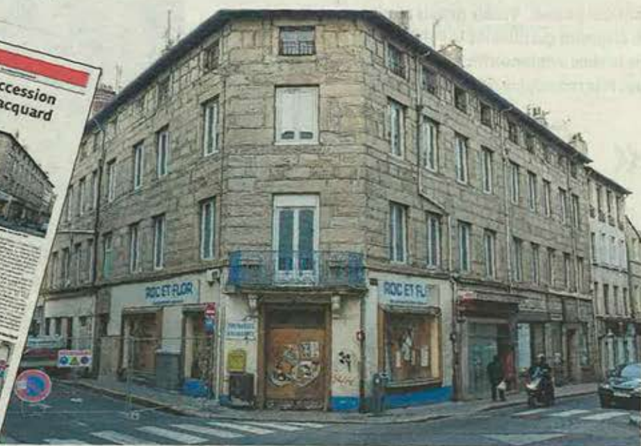
■ L'immeuble avant le début des travaux. Photo d'archives Méliana Rigot
