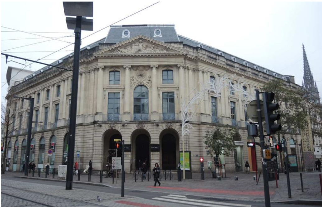
Une banque, des commerces au rez-de-chaussée, et dans les étages, le "Pavillon de l'horloge".
