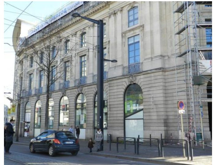
Le bâtiment tel qu'il se présente aujourd'hui, avec les échafaudages prêts pour la rénovation de la toiture. PHOTO DNA
