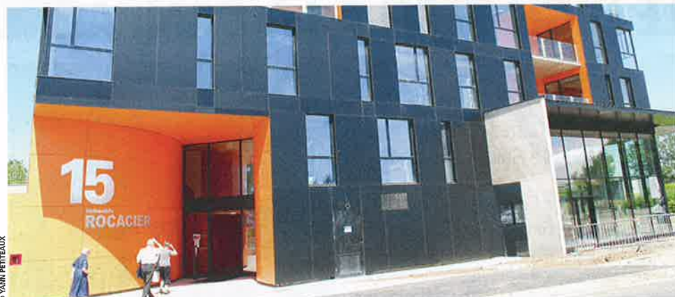
Le bâtiment représente un investissement de 5 M€
