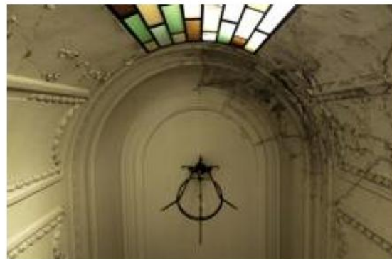
■ Un lustre monumental en pots de peinture surplombera l'escalier protégé.
