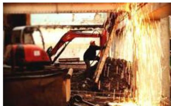
■ La réhabilitation d'un bâtiment de prestige telle que la Condition des soies implique des travaux d'envergure.
